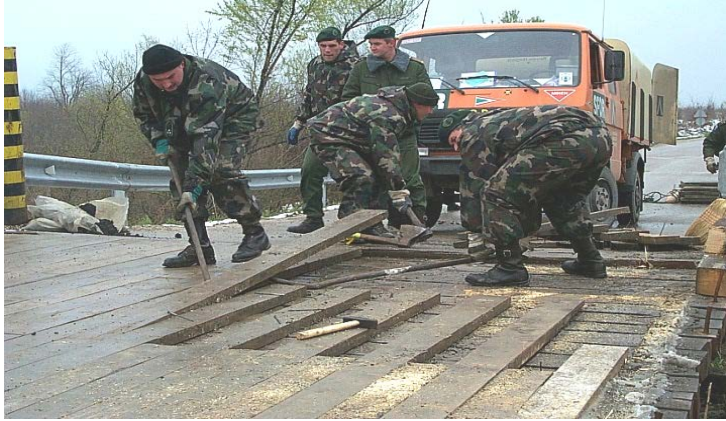
4. sz. kép: Híd karbantartási munkáinak végzése.
