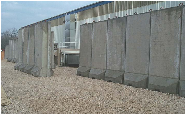
8. sz. kép: Raktárépület vasbeton védőfallal való biztosítása.
