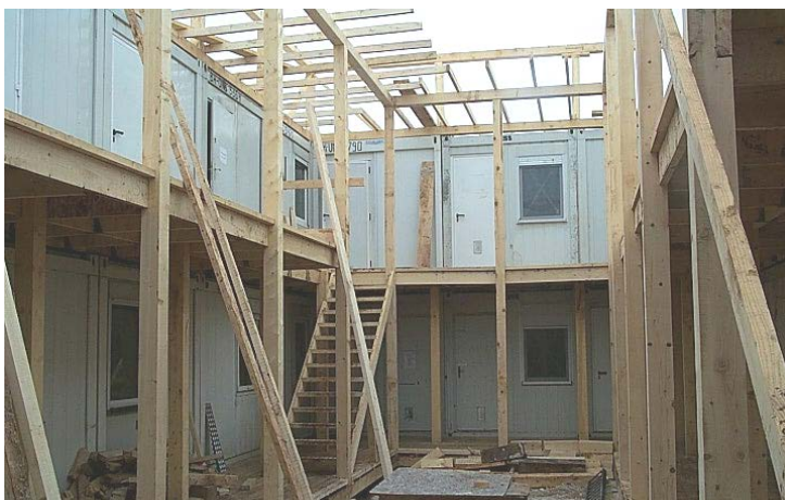
7. sz. kép: A személyi állomány életfeltételeit biztosító építmények építése.
