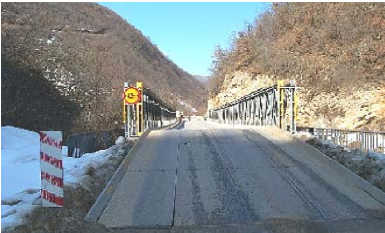
1. sz. kép: Állandó és ideiglenes hidak műszaki felderítése.
