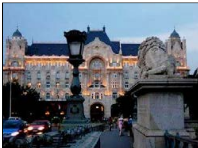
Ponte das cadeias e Hotel Gesham
