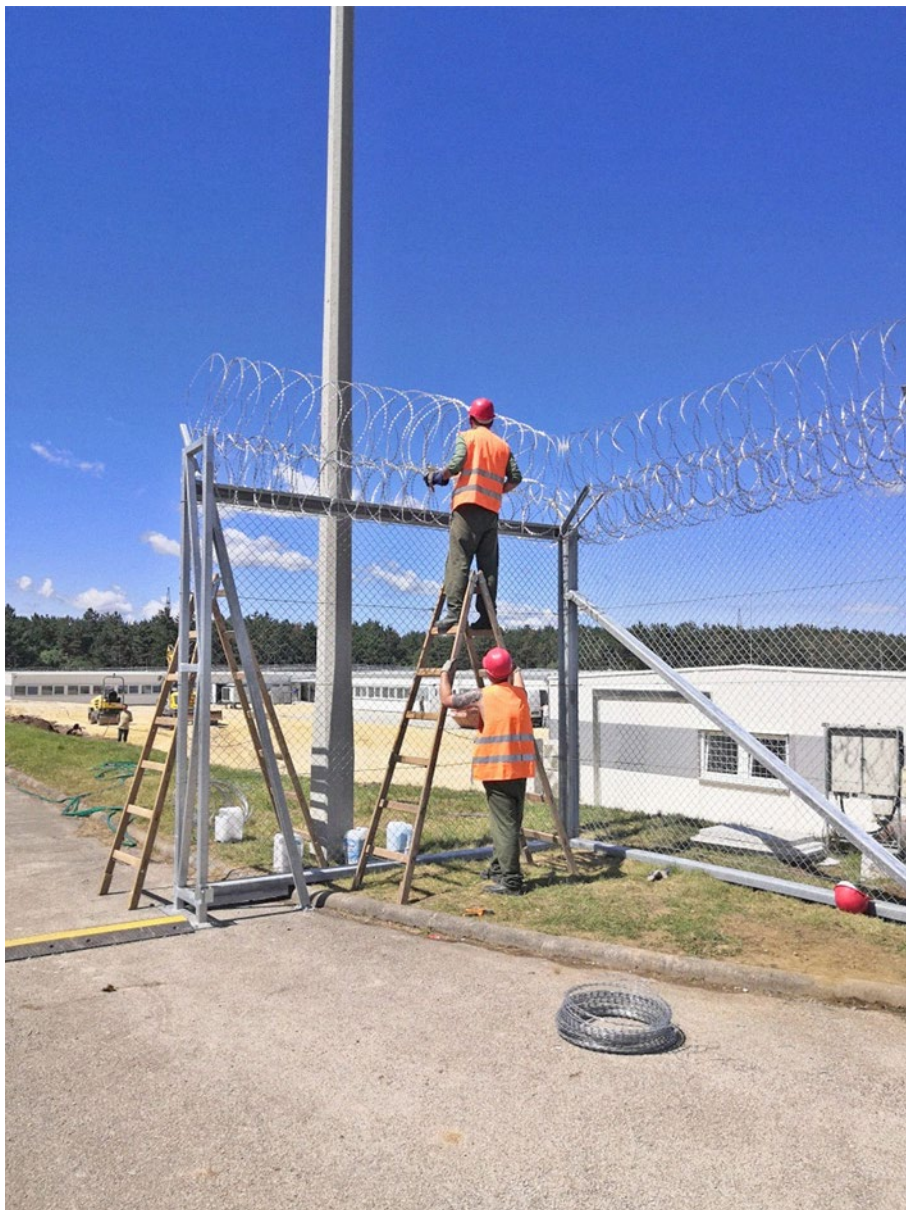
9. ábra: A biztonsági kerítés építése
