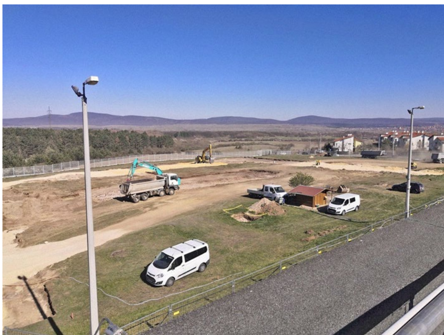
5. ábra: Az épülő II-es objektum 2020. április 7-én
