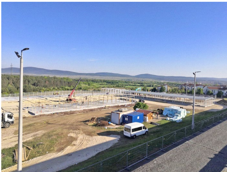
6. ábra: Az épülő II-es objektum 2020. május 11-én
