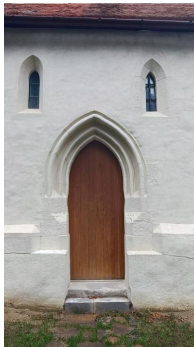
A helyreállított oldalsó bejárat, 2022
