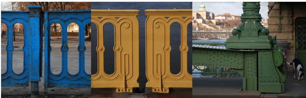
A Margit híd korlátjának változása és a Szabadság híd rekonstrukciónak aligha nevezhető részlete
