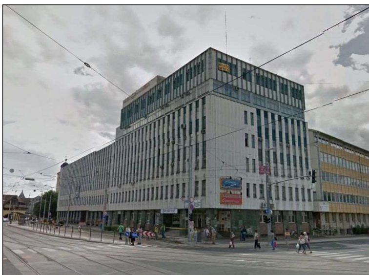
3–5. kép. A Péterfia utca 8. számú ház – a kép bal felső oldalán –, majd az 1975-ös bontás előtt – a kép jobb felső oldalán –, ahol még éppen látható az épület falazata. Később a jelenleg is álló Szövetkezeti székházat emelték a helyére. 24
