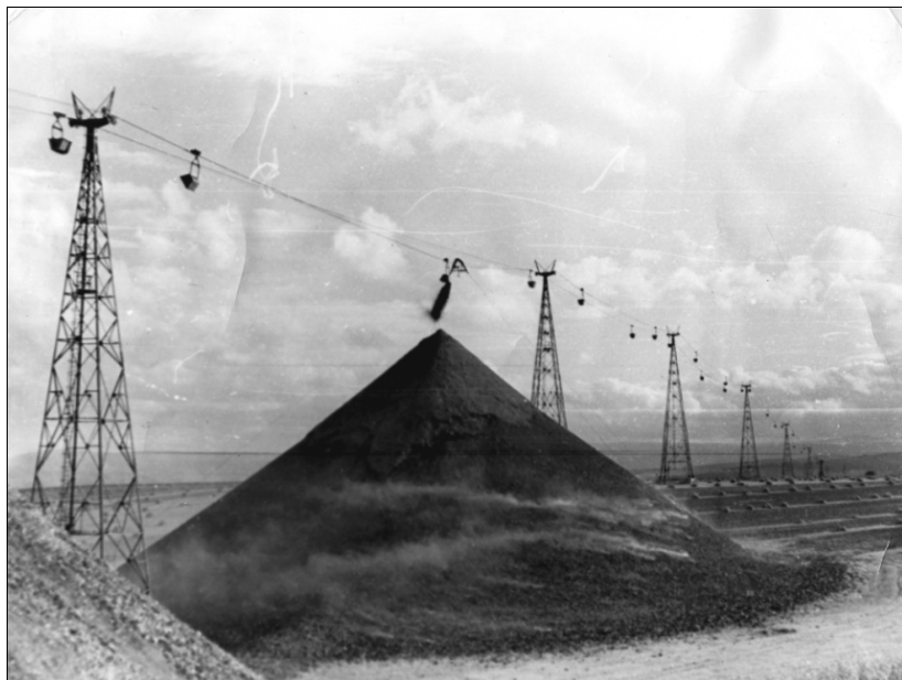
A berentei szénosztályozóra vezető függő drótkötélpálya.
