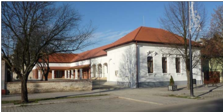
A Családsegítő és Gyermekjóléti Szolgálat megújult épülete
