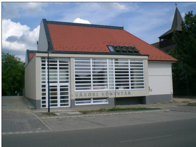
A Városi Könyvtár felújított épülete
