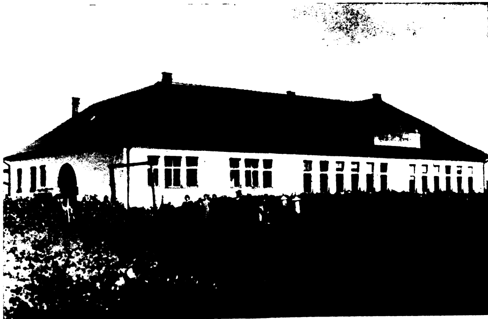
Az iskola épülete.
