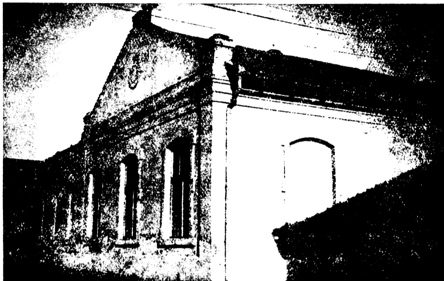
Az iskola főépülete.
