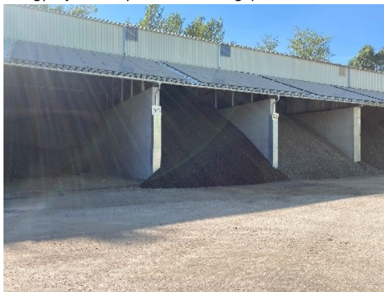
15. ábra: A különböző frakciójú RA alapanyagok fedett tárolása Ausztriában.
