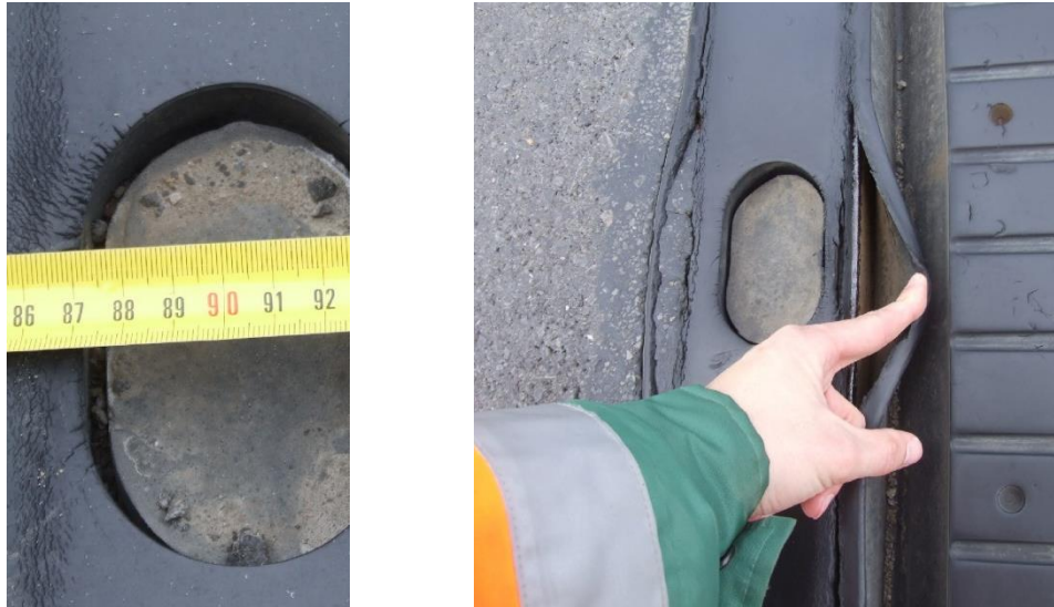
9. ábra: Az elasztomer műgumi öregedési repedései amúgy tökéletes rögzítésű, 18 éves dilatáción (balra) és vulkanizációs hibára visszavezethető gumilválás (jobbra).
