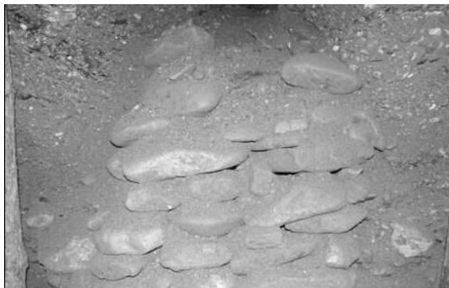
A felszín alatti hálózat legtöbb mellékalagútját kívülről behordott töltelék-anyaggal falazták be
