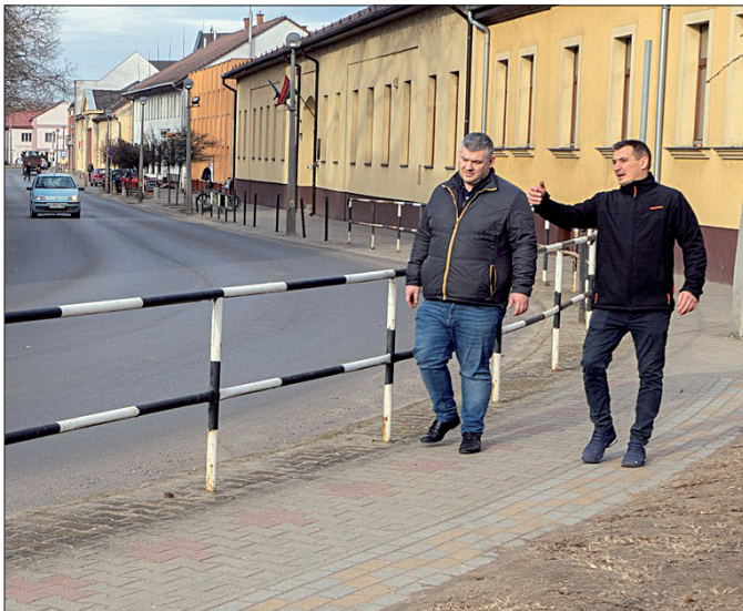
A szakemberek a közelmúltban megjavították a Nagykállói Általános Iskola épülete előtti korlátot.
