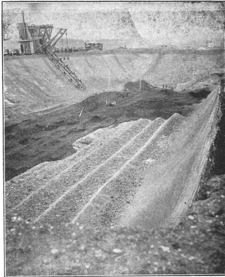
Hungária bánya középütt a szénnel. A kotrógép oldalvást nézve.
