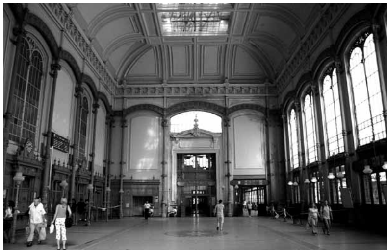
A De Serres/Bernardi féle pénztárcsarnok acél tetőszerkezetét a falaktól beljebb sorakozó Ganz öntöttvas oszlopsor tartja körben
