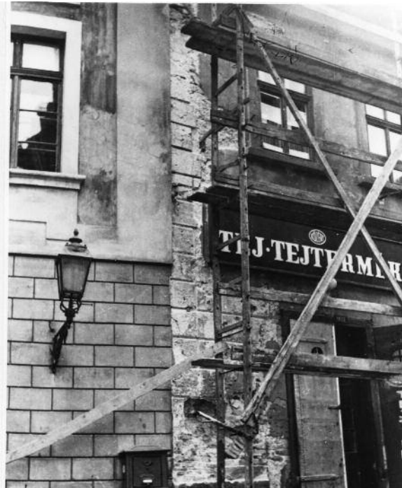
22. A homlokzat kváderes architectúrájának a feltárása 1964. Budapest Főváros Levéltára
