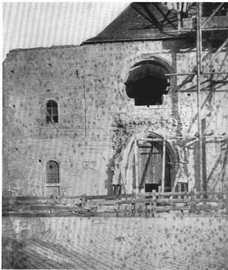
18. A nyugati homlokzat az előcsarnok elbontása után.
