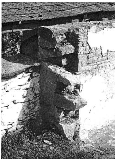
13. kép. Kőfal rakásának technikája
