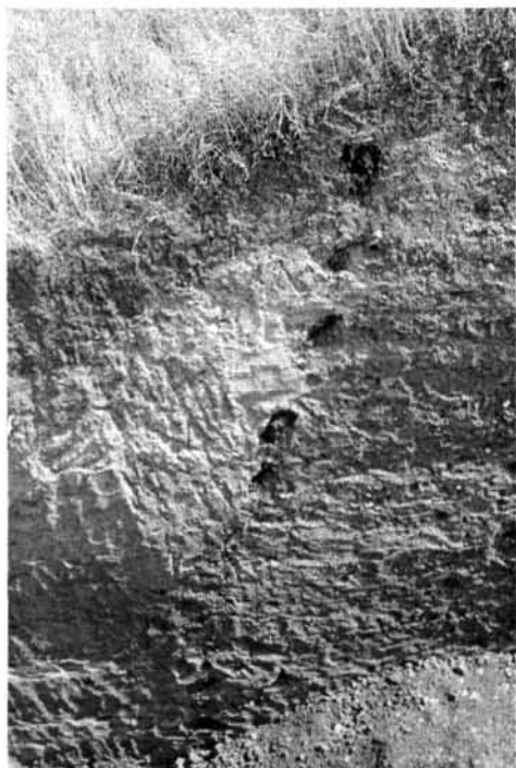
17. kép. Kidülő faszerkezet nyoma a borsodi földvár nyugati sáncátvágásának helyén
