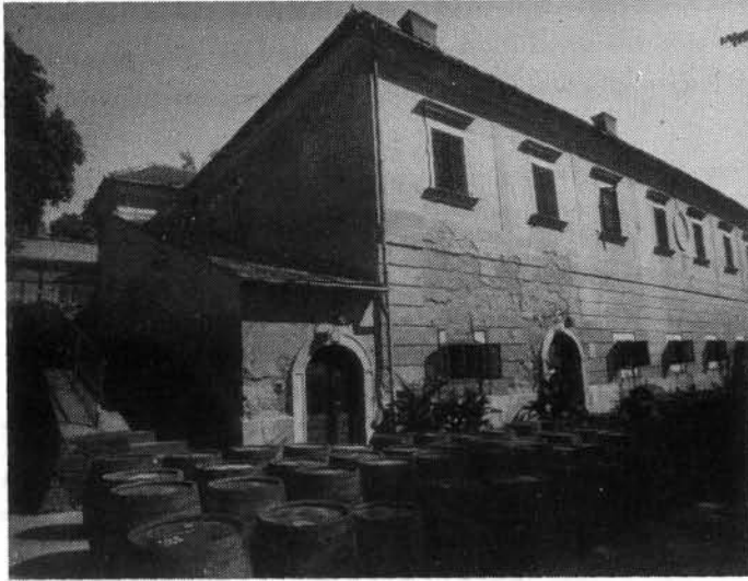
24. kép. Az ún. Rákóczi-borház nyugati homlokzata
