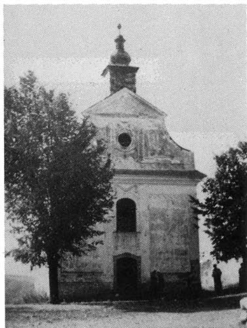
18. kép. A cserépváraljai kápolna főhomlokzata
