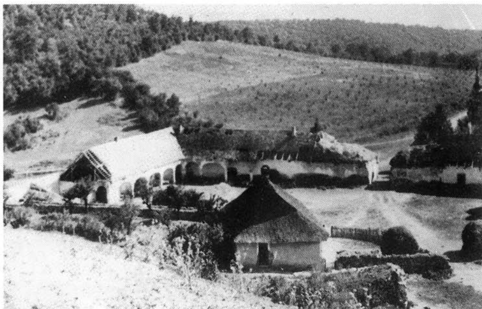
17. kép. Az árkádos tornác maradványai 1960-ban
