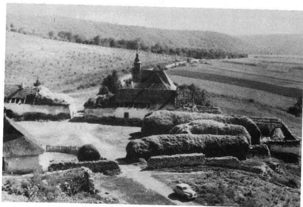
16. kép: Részlet a gazdasági épületek maradványaival 1960-ban
