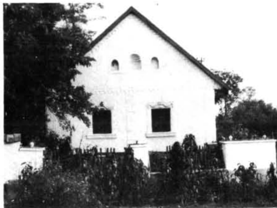
20. kép. Rátka, Iskola tér 1. sz. copf stílusú díszítéssel lakóépület
