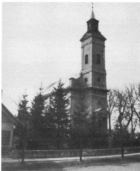
11. kép. Katolikus templom, Mezőcsát
