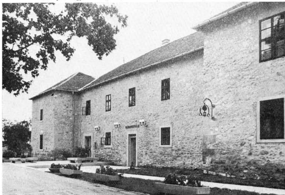
6. kép. A sárospataki egykori trinitárius kolostor helyreállított utcai homlokzata
