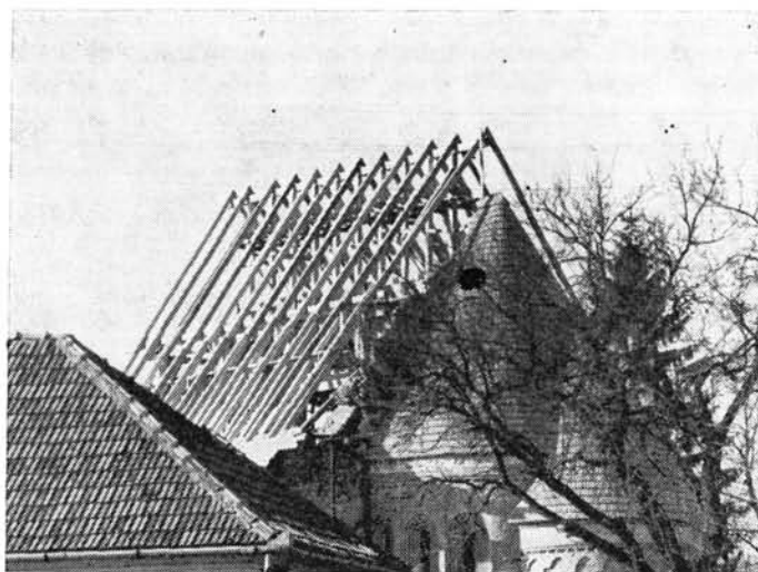
11. kép. Az új tető építés közben
