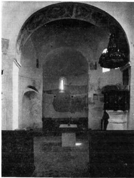
10. kép. A körtemplom belső nézete helyreállítás után
