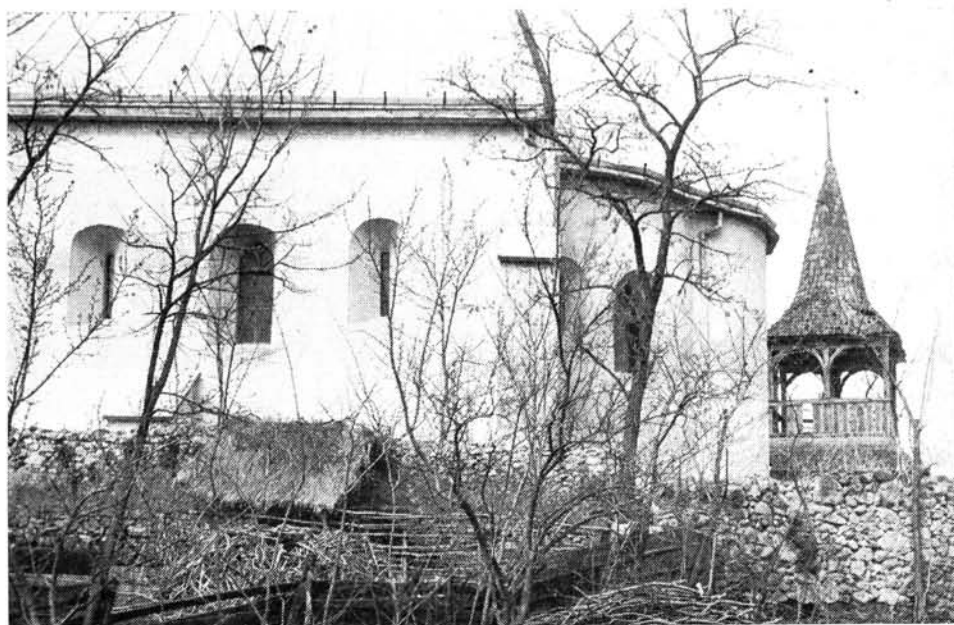
2. kép. Déli homlokzat a helyreállítás előtt
