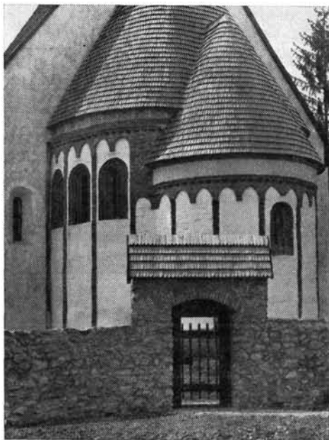
9. kép. A körtemplom DK-i nézete helyreállítás után
