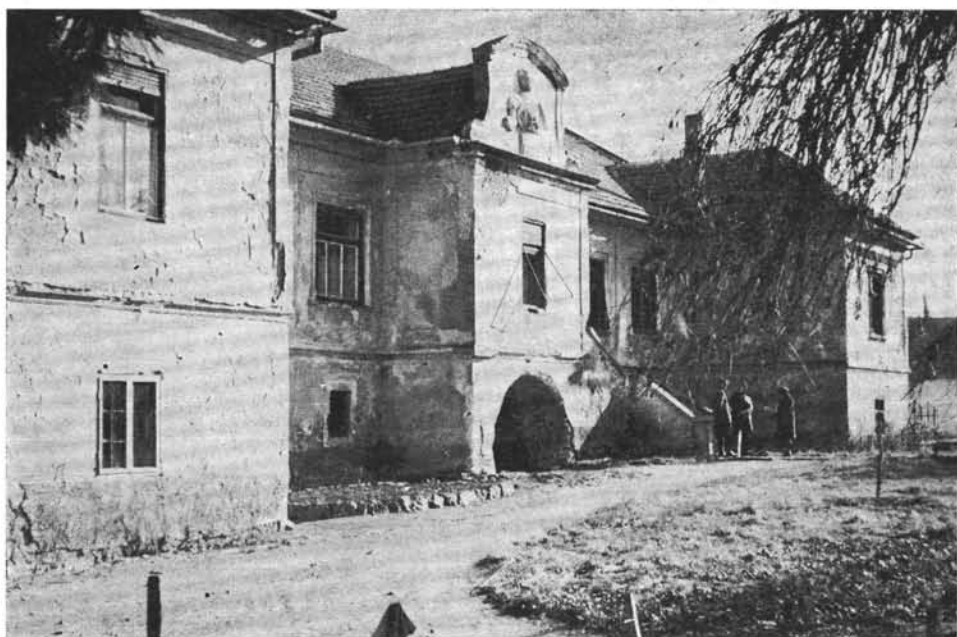
10. kép. A Desseffy kastély főhomlokzata
