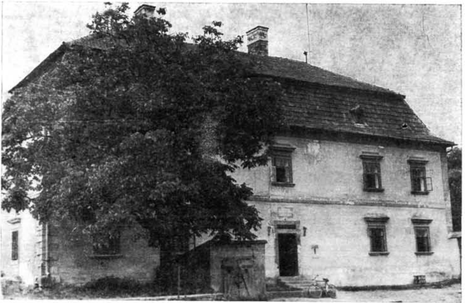
5. kép. A Rákóczi kastély keleti (fő-) homlokzata
