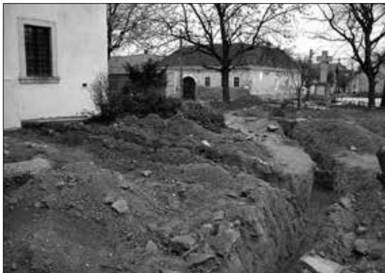
7. kép: Közműárkok a nagytétényi plébániatemplom kertjében Fig. 7: Drainage channels in the yard of the Nagytétény Parish Church
