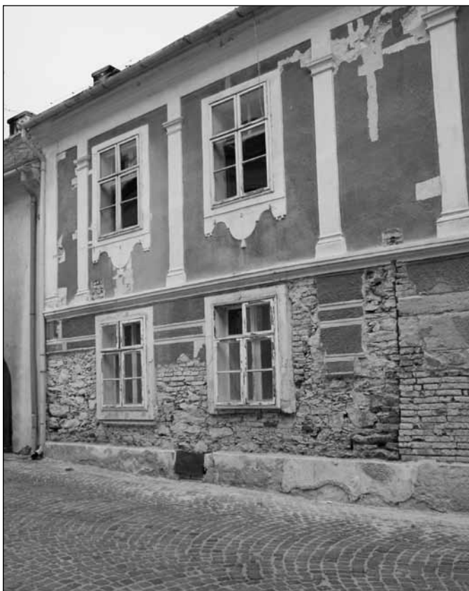
5. kép. Középkori telekhatárra eső falsarok feltárása a Chernel 2. számú épület földszintjén. Fotó: B. Benkhard Lilla 2007.
