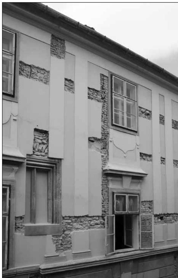
6. kép. Az Új utcai homlokzat a 2017-es kutatás után, az 1964-ben megtalált középkori ablakkal
