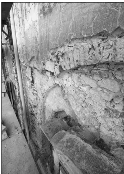
4. kép. Kapcsolt ablak töredéke feltárás közben a Kolostor utcai homlokzat első emeletén. Fotó: Nemes András
