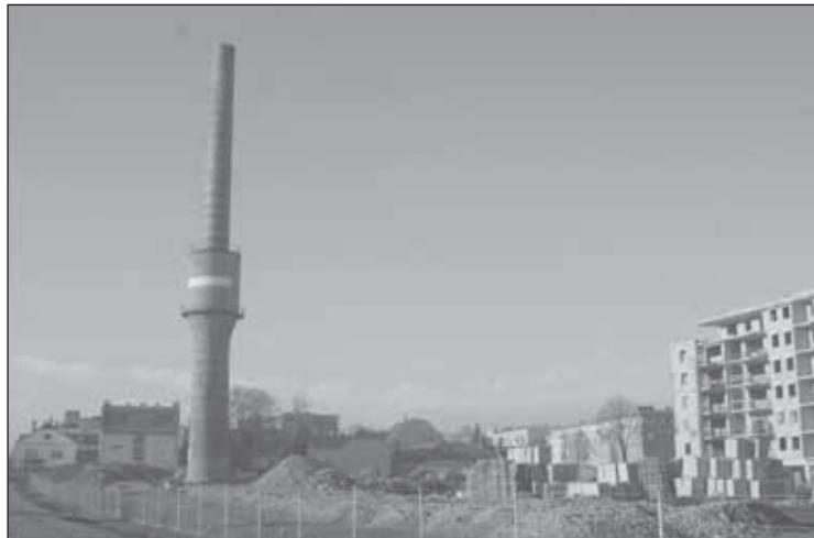
9. a) és b) ábra. Az olajgyári kémény városképi megjelenése a gyárépületek lebontása előtt (Harsányi Eszter építészmérnök gyűjteményéből) és jelenleg
