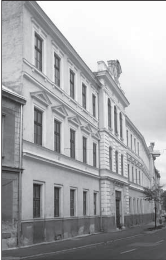
1. kép. A Rákóczi u. 8. utcai homlokzata 2016-ban. Fotó: Csekő Ernő.
