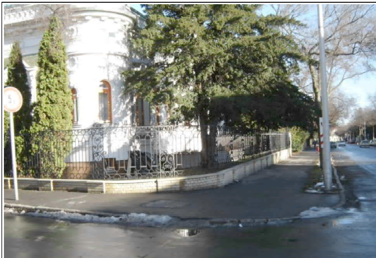
6. kép: Stauffer-villa felújításakor a régi kovácsoltvas kerítést és kaput is felújították
