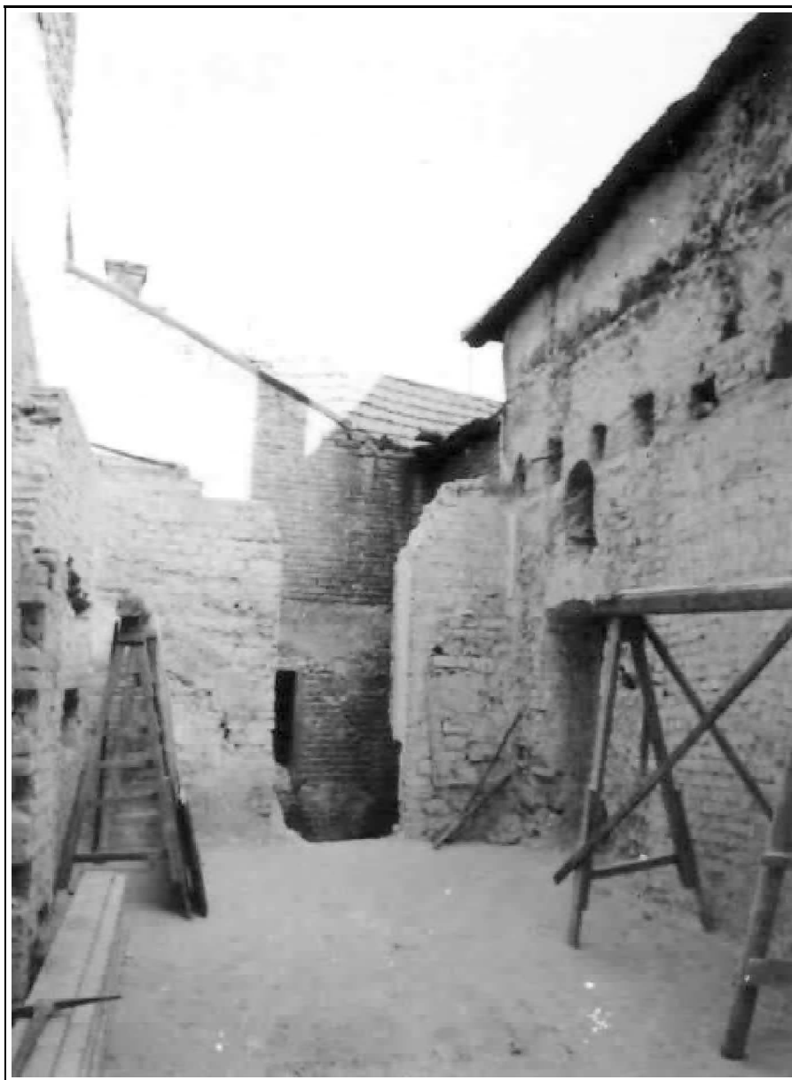
5. kép A zsinagóga külső fala feltárás közben (Új utca 22-24.; 1972)
