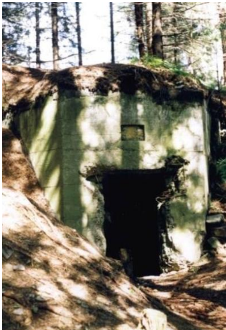
7. kép: Sajnos kevés az épségben fennmaradt bunker Uzsok környékén. Ennek egyik oka, hogy heves harcok folytak itt, a másik, hogy a szovjetek a bunkereket felrobbantották.
