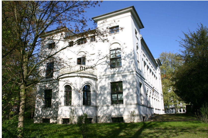
1. kép: A Georg Eckert Institut (GEI) épülete
