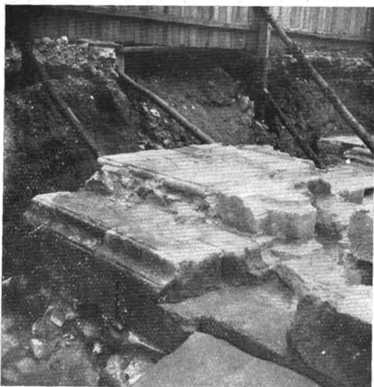
5. kép. Az 1. sz. pillér oldalnézete.
