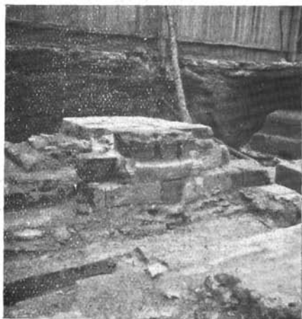
7. kép. A 2. sz. pillér a támasztó pillér eltávolítása után.
