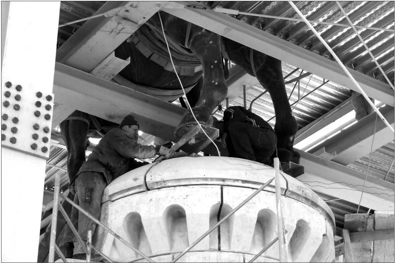
A restaurátorok a több tonna súlyú alakot először biztonsági okokból próbaszerűen eresztették rá a talapzatra
