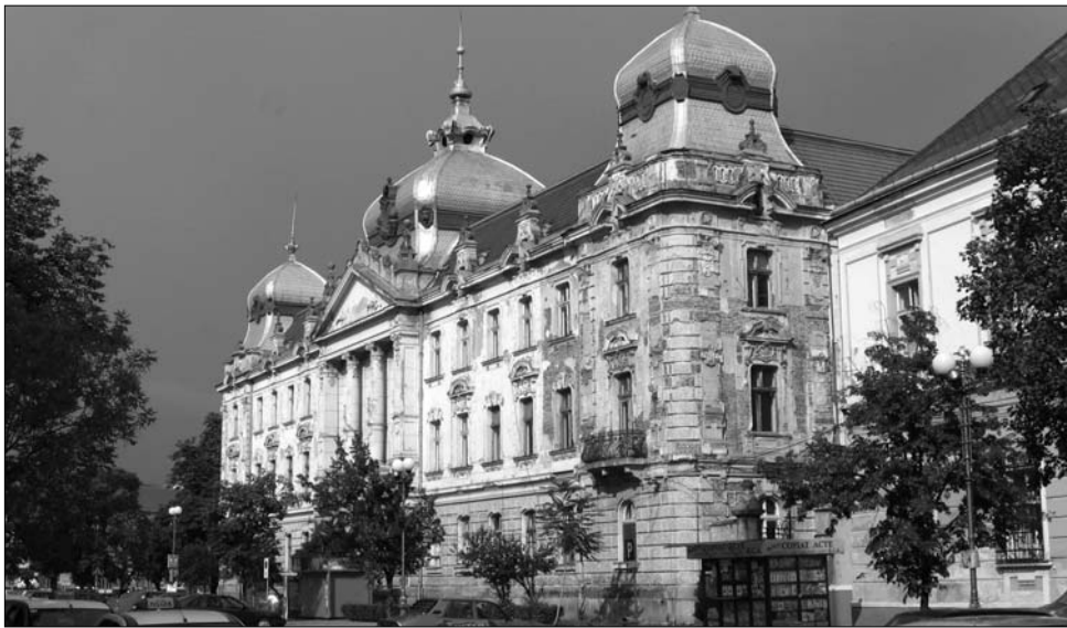
Rossz állapotban van a Rimanóczy Kálmán által tervezett és kivitelezett Pénzügyi Igazgatósági Palota is
