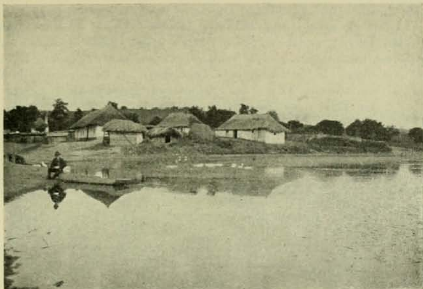
16. ábra. A baldi tó a Sármási patak völgyében (mesterségesen duzzasztva).
