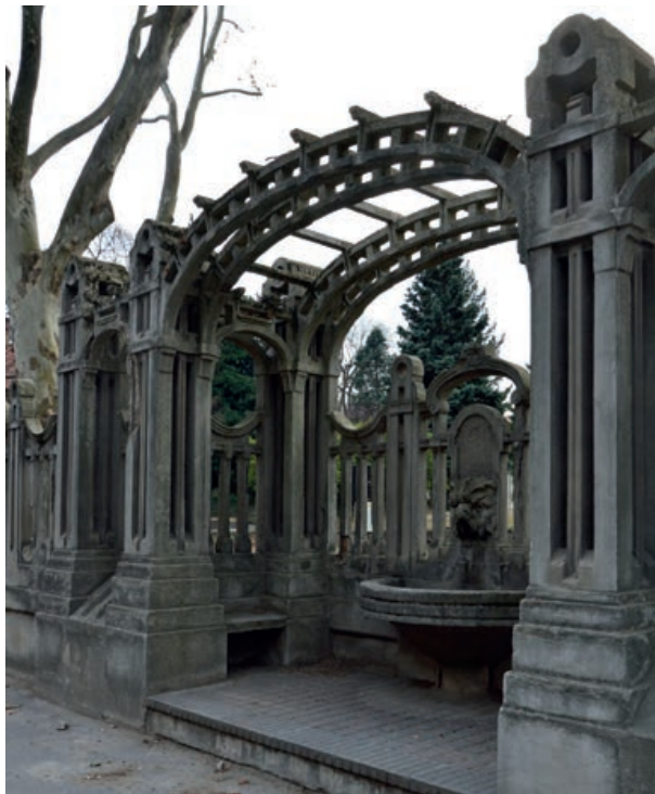
9. Újpesti vízmű kerítése, részlet Fotó © F. Dóczy Erika, 2022
