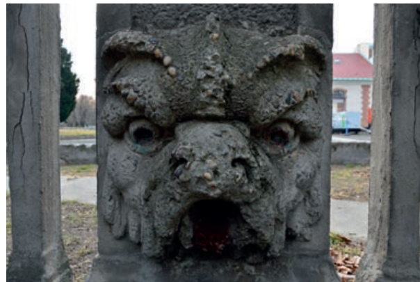
10. Vízköpő az újpesti vízmű kerítésén Fotó © F. Dóczy Erika, 2022
