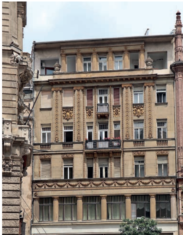
3. Alpár Ignác: Girardi-ház, Budapest, Ferenciek tere 11. (az átalakított főhomlokzat), 1914–1915 Fotó © Rozsnyai József, 2020
