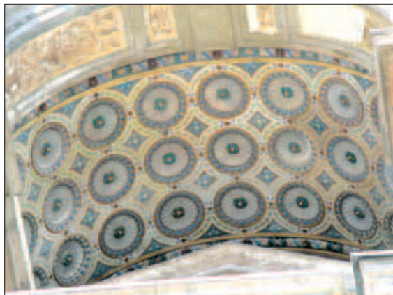
8. kép. Az Operaház nyitott árkádjának kazettás dongaboltozata
