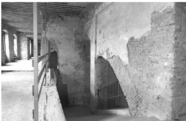
20. kép. 1850-es években átalakított főlépcső, egykorú öntöttvas ráccsal. Fotó: Hack Róbert, 2011
