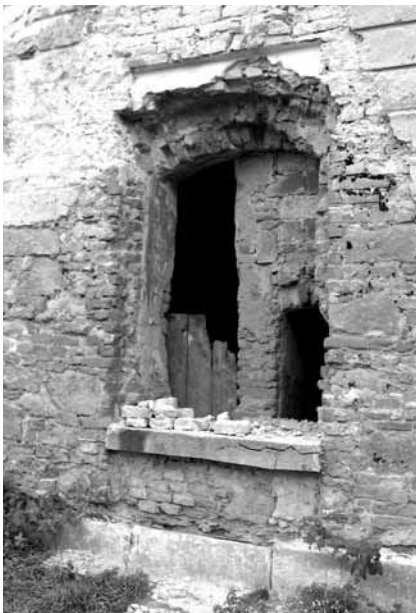
30. kép. A nyugati pavilon klasszicista tükrös ablaka és a – befalazásával egy időben – mögötte létrehozott, Ybl által tervezett, nagy, föld alatti derítőhöz kapcsolódó, közös válaszfalú mosdó és illemhely. Fotó: Mentényi Klára, 1997
