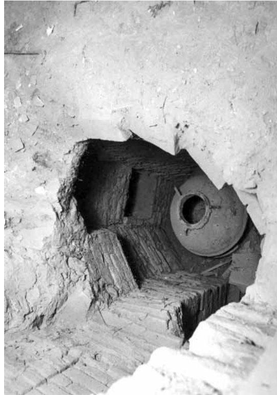
28. kép. A nyugati szárny északra eső pincéjében fennmaradt öntöttvas ciszterna, a téglafalban kialakított vízvezető nyílással. Fotó: Mentényi Klára, 1997
