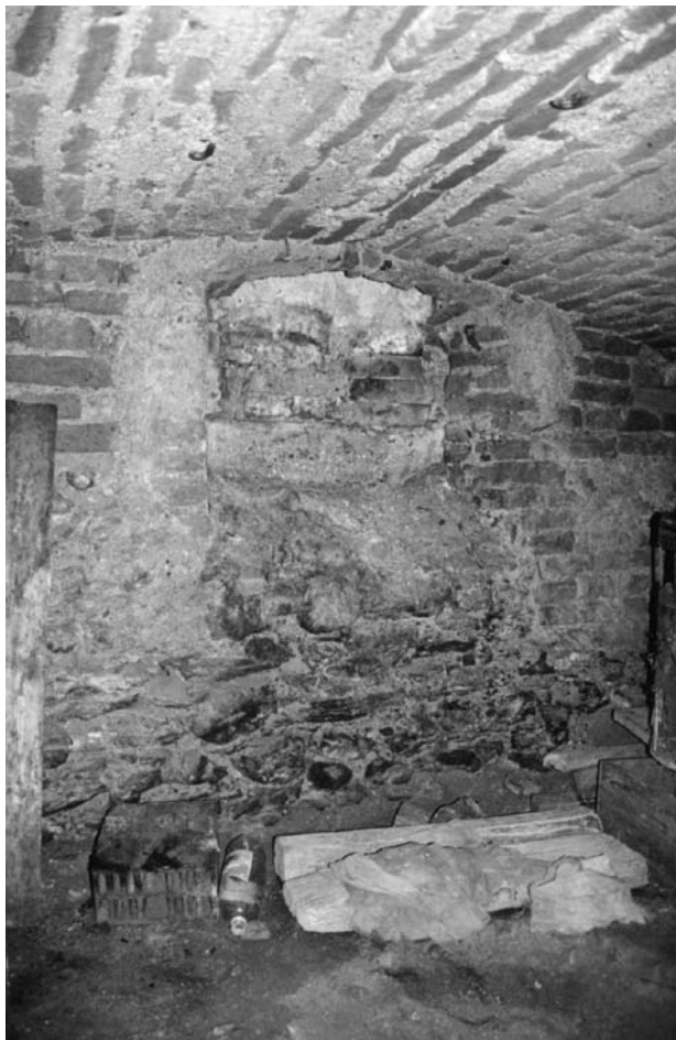
2. kép. A pincében megfigyelhető terméskő falak (B. Benkhard Lilla felvétele, 2004)
