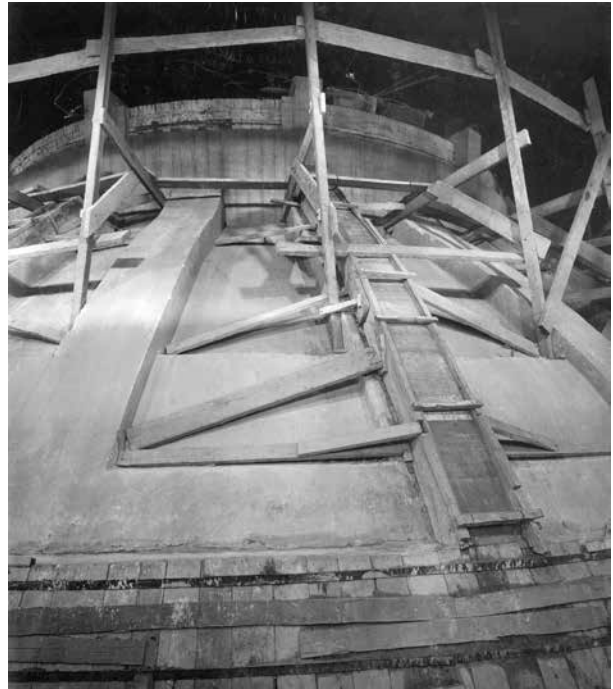
2. „A boltzott kupola tetején a földrengés elleni biztosítás végett készült vasbeton erősítések” Hollenzer László fényképsorozata (26. felvétel), 1913 Esztergomi Prímási Levéltár, Fényképtár, no. 3120
