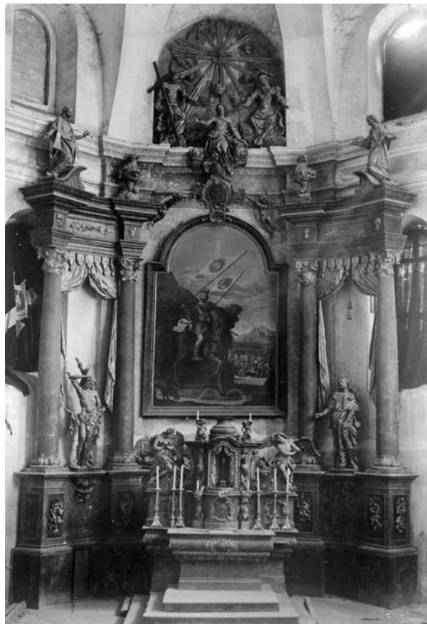
8. A főoltár a felújítási munkálatok megkezdése előtt. Lehrbaum szerencsi fényképész felvétele, 1931 Magyar Építészeti Múzeum és Műemlékvédelmi Dokumentációs Központ, Fotótár, ltsz. 15.221PD
