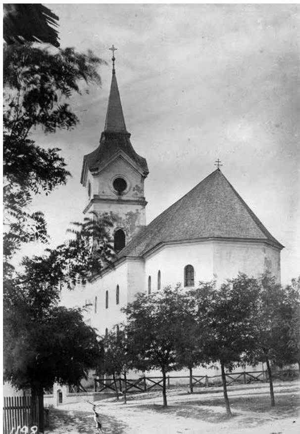
1. A tállyai r. k. templom keletről, 1911 Magyar Építészeti Múzeum és Műemlékvédelmi Dokumentációs Központ, Fotótár, ltsz. 2054P
