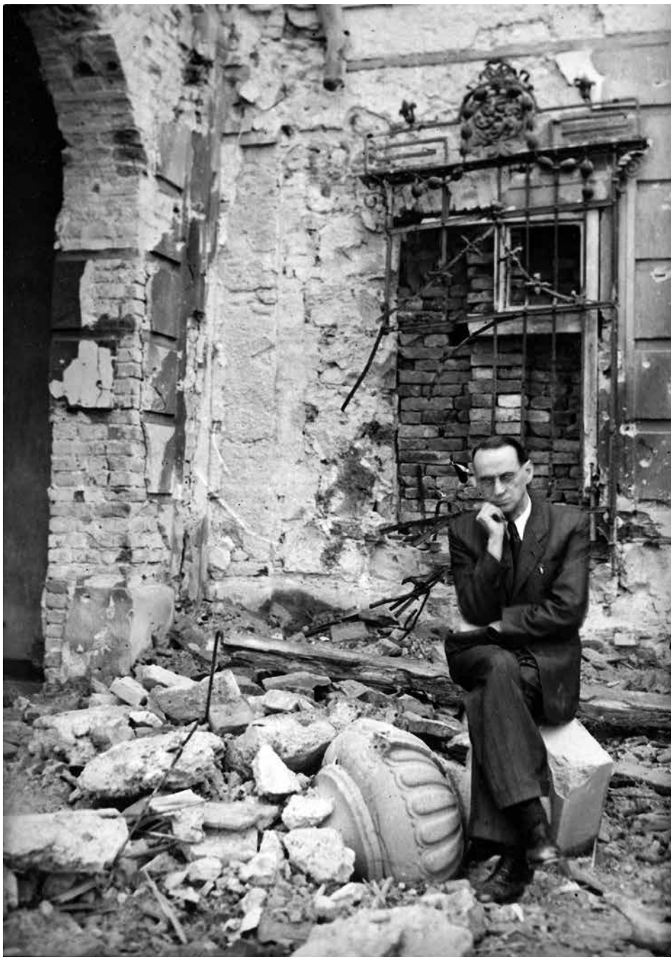
7. Az épület az ostrom után: Carl Lutz a kertben Fortepan, no. 105789
