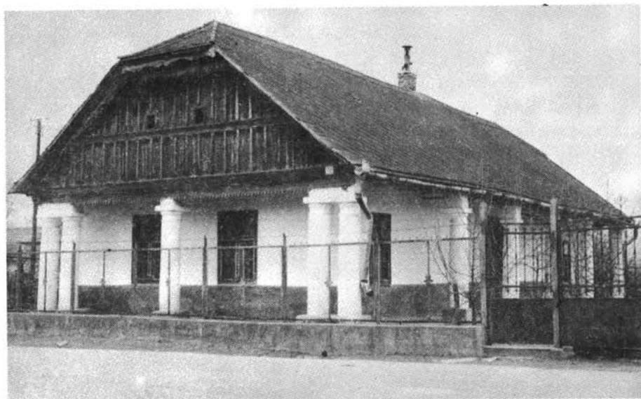
5. kép. Lakóház, Szabolcsbáka, Kossuth u. 15. SMF 326. Erdész S. 1973.)
